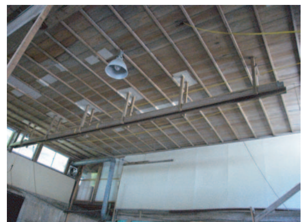
最大級の和紙を漉く時に利用された天井クレーンの木製レール
